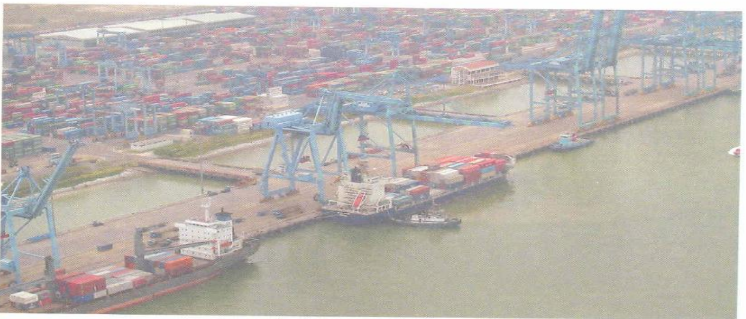
Terminal kontena Pelabuhan Klang. Port Klang container terminal.
